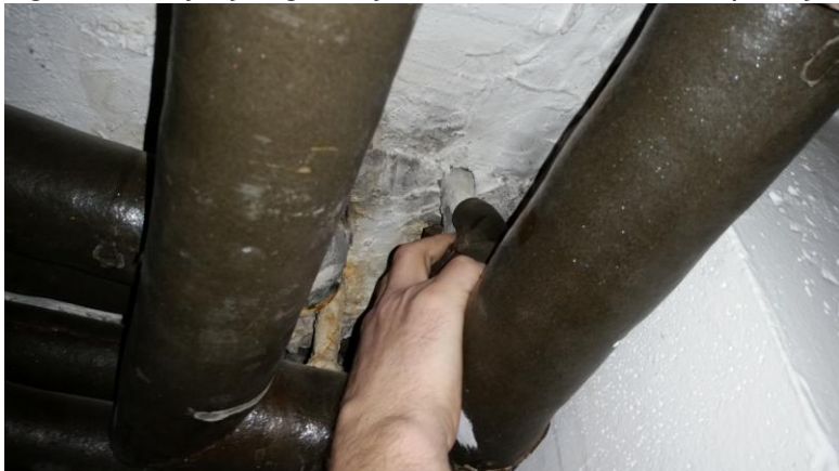
Slika 2 - neizolirana vertikala v instalacijskem jašku
