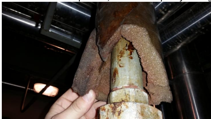
Slika 1 - dotrajana toplotna izolacija
